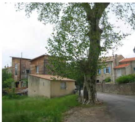
Surrélévation d'une ancienne remise en pierre, à Saint Bazille de Putois (34), architecte ?
