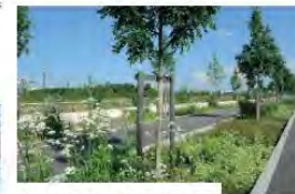
Fossé enherbé permettant l'infiltration naturelle des eaux pluviales - ZAC Andromède à Bagnac-sur-Célé. Source : http://www.ecoquartier-andromede.fr
