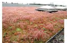
Toiture végétalisée : tapis de médian en fleur sur le restaurant universitaire du Mirail. L'énergie du soleil est stockée par les plantes et le substrat, elle ne participe ni au réchauffement de l'atmosphère, ni à celui du bâtiment. Source : végétal.
