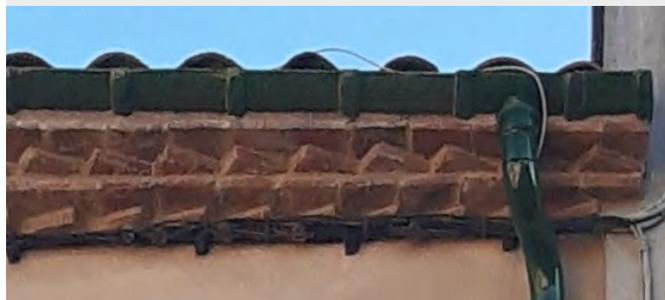
Les **chéneaux**, les **descentes** et les **gouttières** en zinc, en cuivre ou en terre cuite vernissée ont leur importance dans la protection de la façade car ils contribuent à éloigner l'eau de la façade. La corniche en terre cuite, recouverte par les tuiles, est appelée *tortugada* (prononcer *tour-tougade*).
