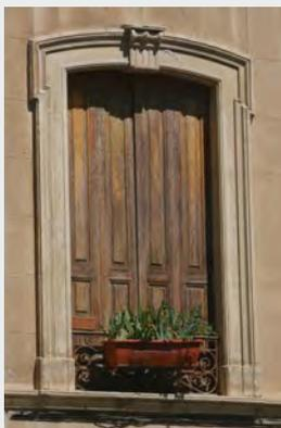
Contrevents à brisures verticales (se pliant en tableaux dans le sens de la hauteur)
