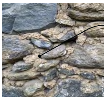
Mur en pierre avec hourdage en terre à Taurinya
