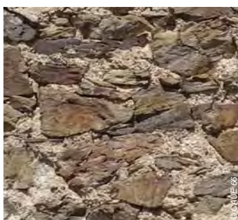
Mur de moellons* de pierre schisteuse à Jujols
