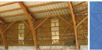
Chêne massif lamellé-collé d'origine locale au nord, constitué par l'interpénétration de pièces traitées, dans des proportions élevées des deux sens de bordage bois.
