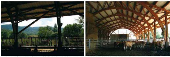
La structure en bois lamellé-collé est stabilisée par quatre piques en bois massif, entièrement locales et œuvre sur le pays, offrant ainsi une vue panoramique sur les montagnes locales.
