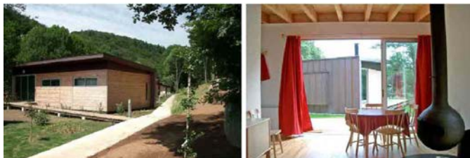
Les façades sont réalisées en planche de pin Douglas sur les façades Est, Sud et Ouest. Le zinc recouvre le toit.
