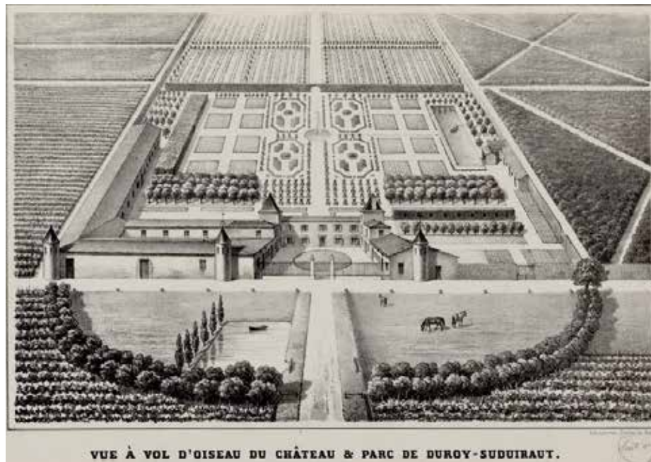
VUE À VOL D'OISEAU DU CHÂTEAU & PARC DE DUROY-SUDUIRAUT.
